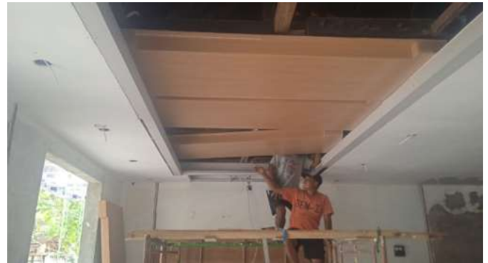
Gambar 3. Pengawasan Kegiatan pemasangan plafond
